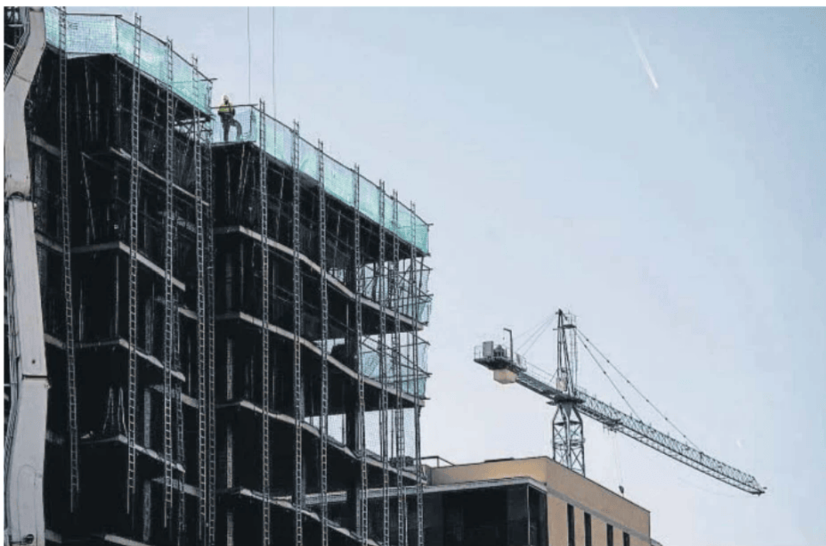
Viviendas en construcción en la Zona Franca, en una imagen de principios de año
